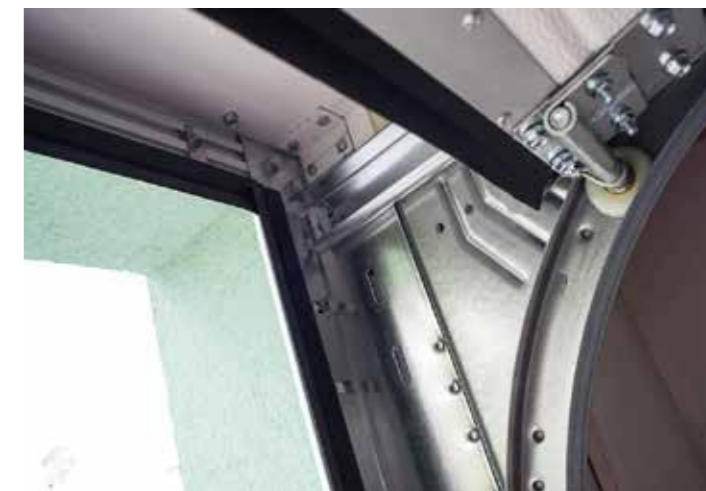
▲ RSV; detail rámu a pojezdových kolejnic
