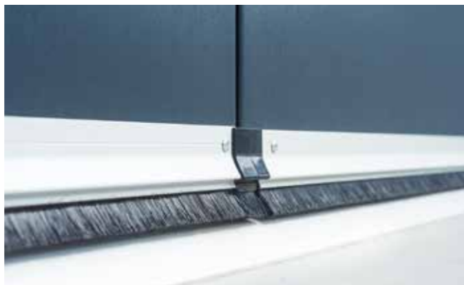
Posuvná vrata; detail spodní těsnění ▲
